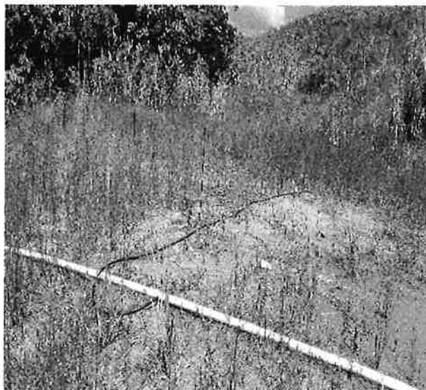
Fotos N°3-6. Medidas de control de sedimentación por medio de barreras naturales de cobertura vegetal.
