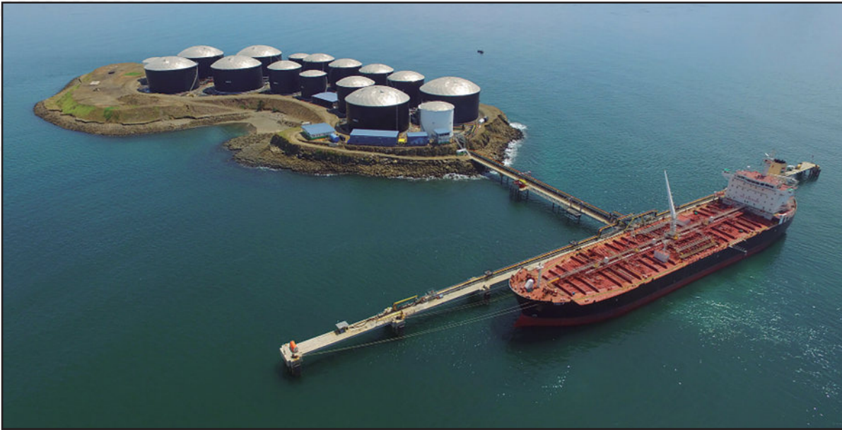
Imagen 4. Terminal de hidrocarburos Melones. Fuente: Autoridad Marítima de Panamá, febrero 2019. Foto ilustrativa.
